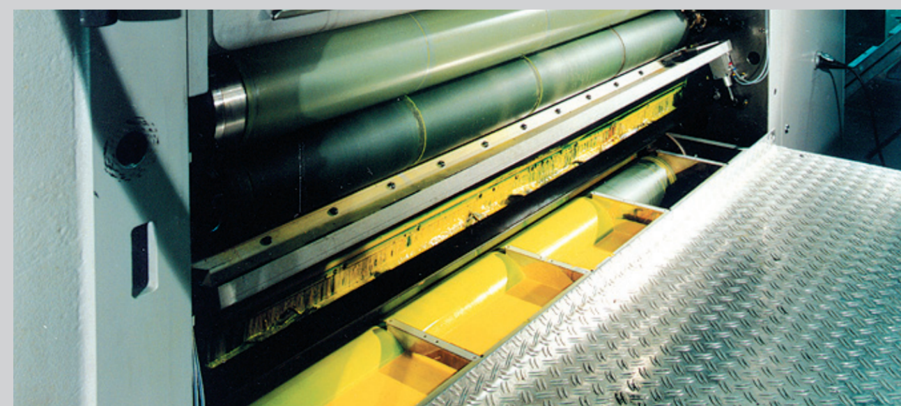
La producción fiable precisa un buen mantenimiento y un ambiente limpio.
